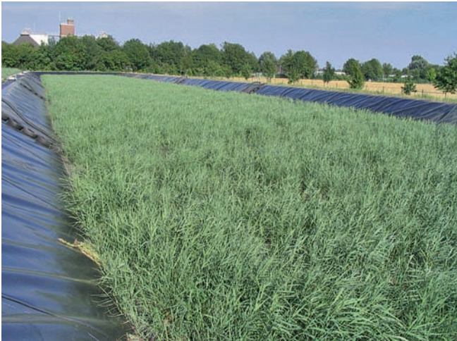
Abb. 1: Klärschlammvererdungsanlage Hönnepel (acht Beete, 540 t TS) (Foto: EKO-PLANT)
