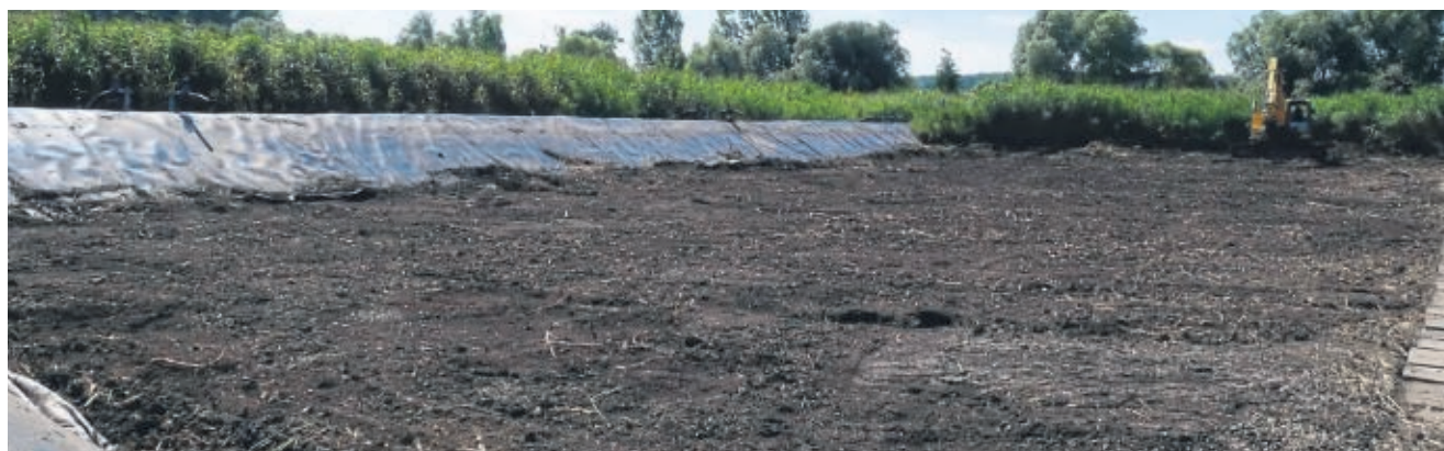
So sieht ein Schilfboot nach einer Räumung aus. Die Klärschlammvererde wird als Düngemittel benutzt.
