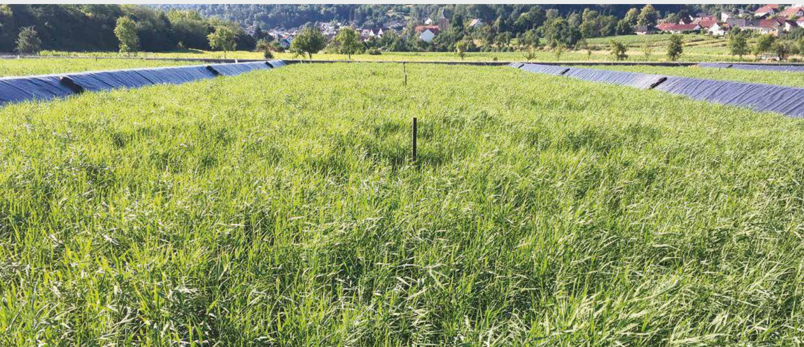
Bild 1 Natürliche und umweltfreundliche Klärschlammvererdung in Vererdungsbeeten
