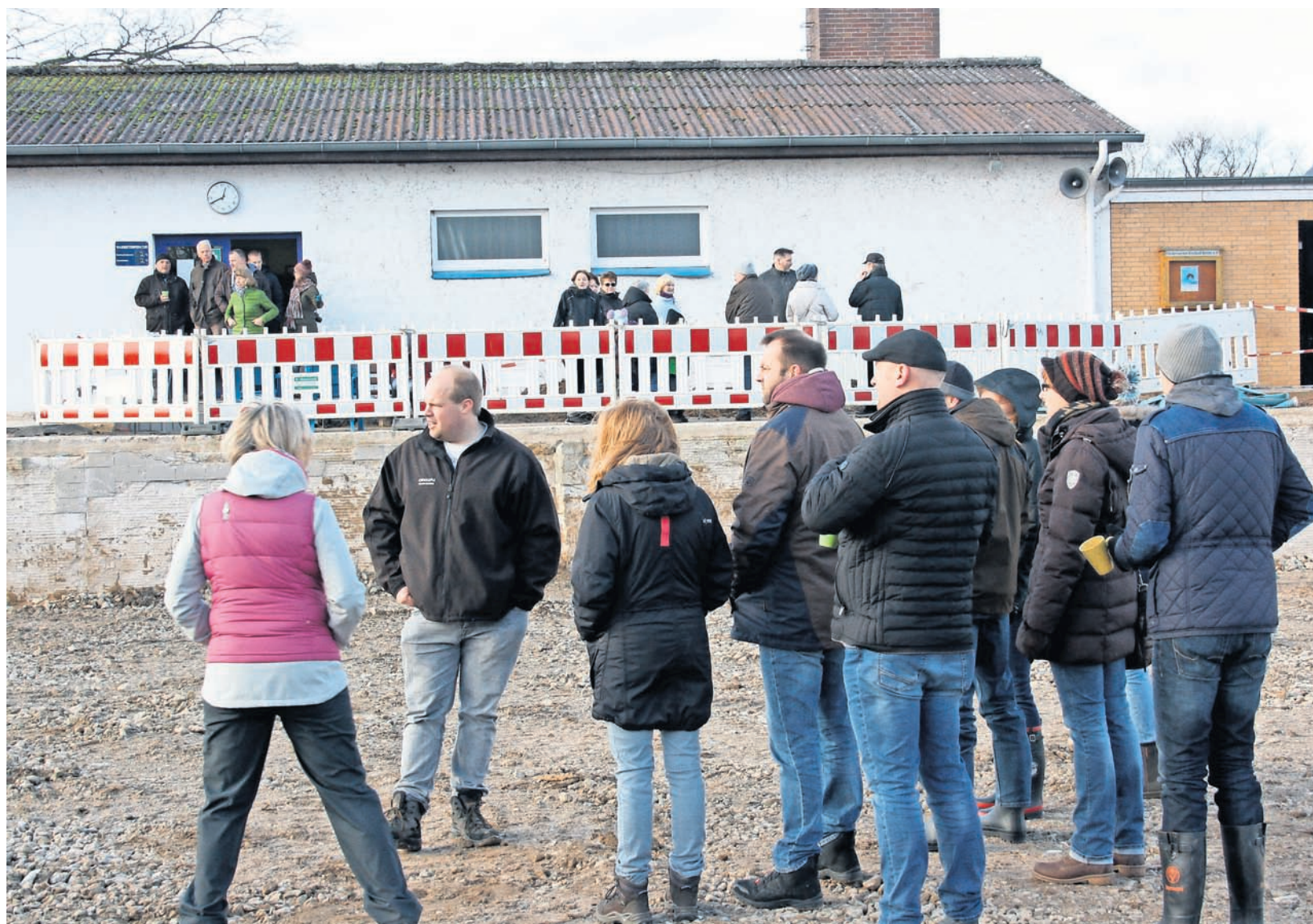
Was passiert beim Umbau der Batze zum Biobad? Die Baustellenführer haben reichlich zu tun.
