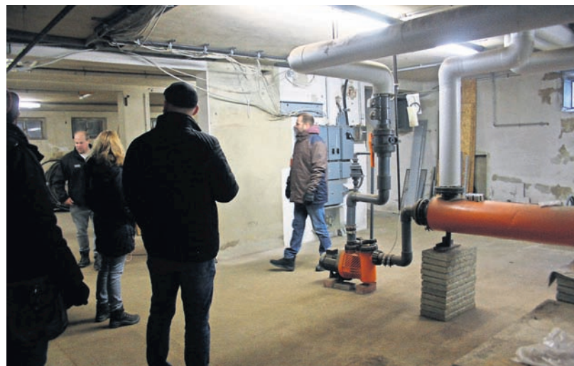
Der Keller soll am 19. Januar gestrichen werden, es werden noch Helfer gesucht.
