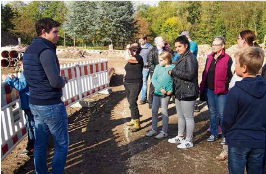
„Wir sind noch im Zeitplan“: Florian Englert (links), Geschäftsführer der Kluterthöhle und Freizeit GmbH, führt die Gruppen durch die Baustelle.
